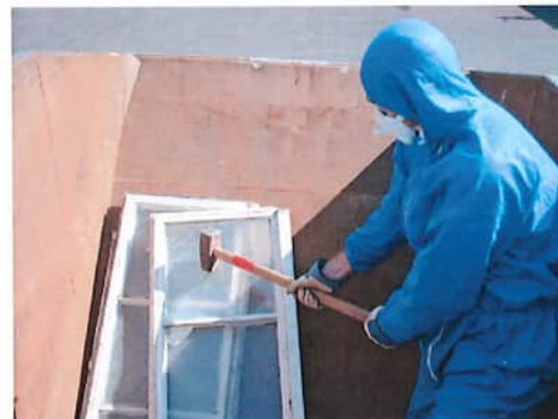
1 Ausglasen mit einem Hammer
