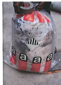
4 Kunstsacksack mit der Kennzeichnung Asbest
