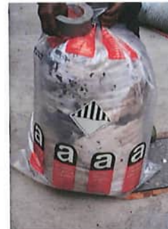
4 Kunstsacksack mit der Kennzeichnung Asbest
