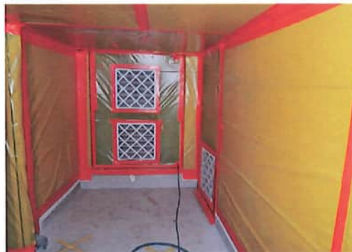
1 Sanierung: Zone mit UHG (Unterdruckhaltungsgerät) und Schleuse
