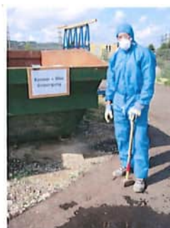
2 Arbeiter mit korrekter Persönlicher Schutzausrüstung
