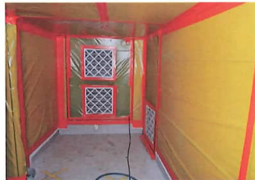
1 Sanierung: Zone mit UHG (Unterdruckhaltungsgerät) und Schleuse
