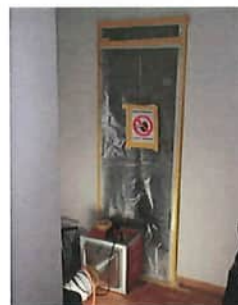
5 Abgetrennte Sanierungszone mit Unterdruckgerät
