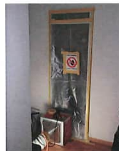
5 Abgetrennte Sanierungszone mit Unterdruckgerät
