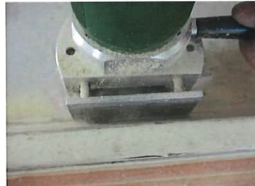
1 Entfernen von Fensterkitt mit einer Fugensäge
