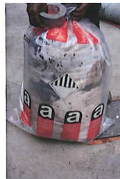
6 Kunstsacksack mit der Kennzeichnung Asbest
