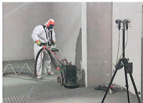
2 Sanierung: Mobile Bodenschleifmaschine mit Quellenabsaugung
