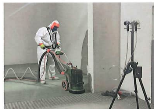
2 Sanierung: Mobile Bodenschleifmaschine mit Quellenabsaugung
