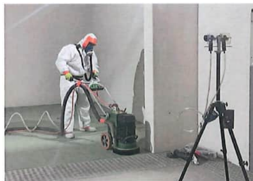
2 Sanierung: Mobile Bodenschleifmaschine mit Quellenabsaugung
