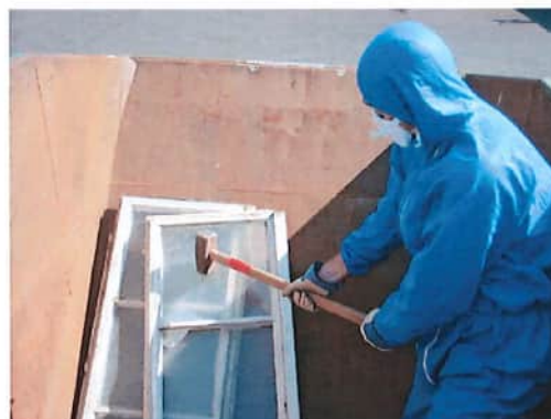
1 Ausglasen mit einem Hammer
