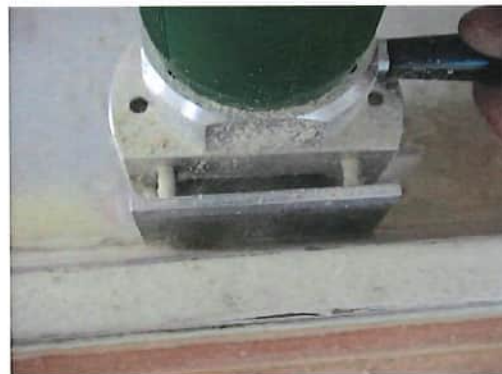
1 Entfernen von Fensterkitt mit einer Fugensäge
