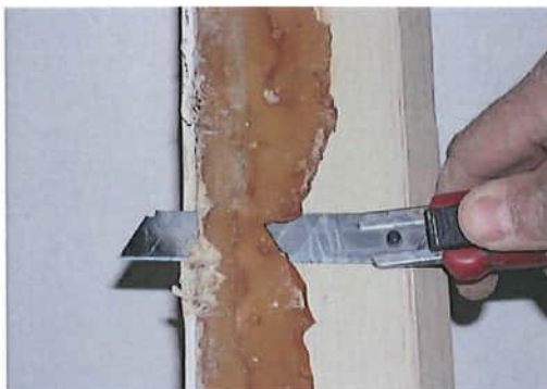
4 Abtrennen des Kitts von der Unterlage mit einem Japanmesser
