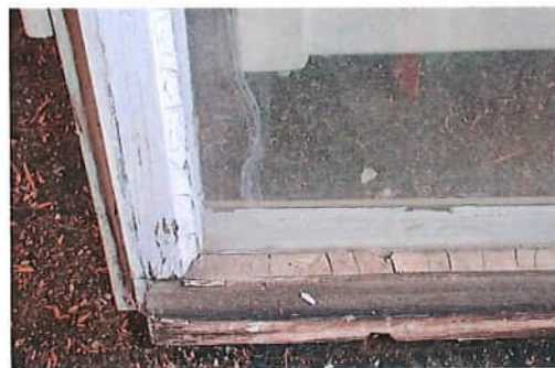
1 Asbesthaltiger Leinoil an einem Holzfenster
