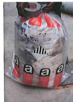
4 Kunstsack mit der Kennzeichnung Asbest
