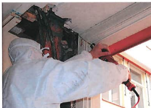
1 Aufschneiden des Fensterrahmens mit einer Fuchsschwanzsäge
