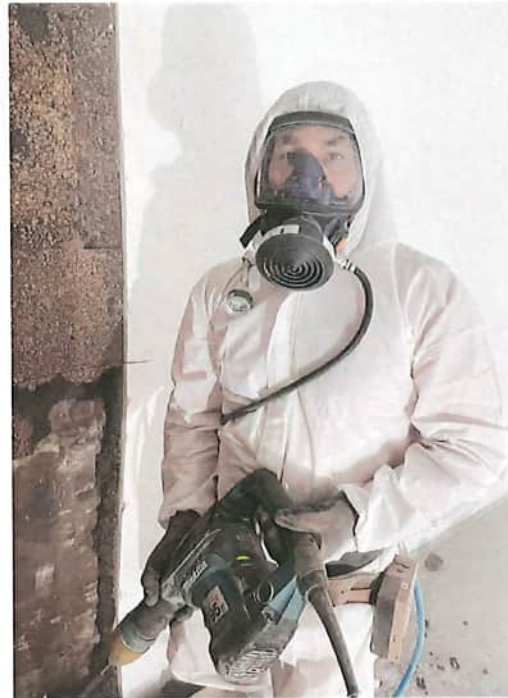
3 Umgebungsluft unabhängiger Atemschutz oder Gebläsefiltergeräte, Einweg-Schutzzanzug und Handschuhe
