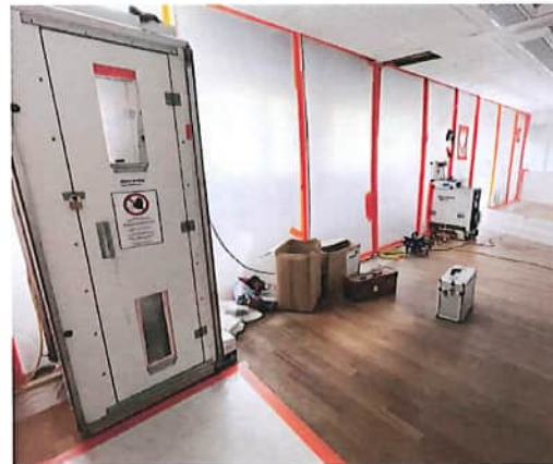
1 Umbau: Zone mit UHG (Unterdruckhaltungsgerät) und Schleuse
