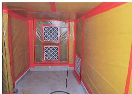
1 Sanierung: Zone mit UHG (Unterdruckhaltungsgerät) und Schleuse
