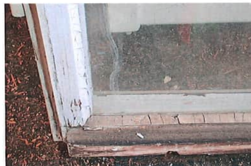
1 Asbesthaltiger Leinöl kitt an einem Holzfenster
